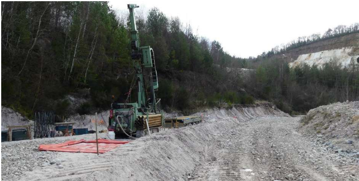
Illustration : Foreuse et matériel en place pour la campagne de sondages Phase 1, le long d'une piste existante – Echassières février 2022 - source photographique : Mica Environnement
