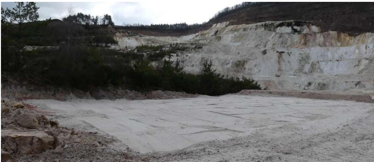
Illustration : Plateforme préparée pour la campagne de sondages Phase 1, le long d'une piste existante Echassières février 2022 - source photographique : Mica Environnement
