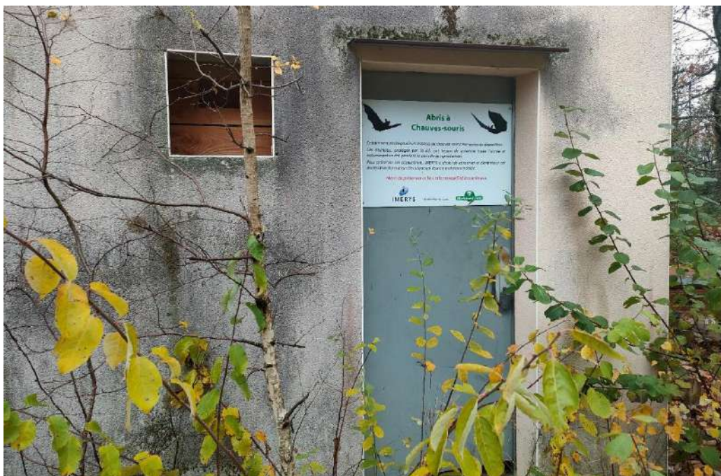
Entrée de l'ancien poste antenne faisant office de gîte à Chiroptère, à proximité de P3_E05
