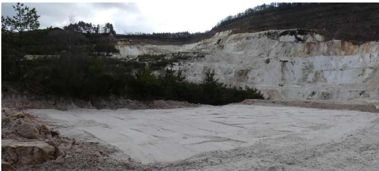
Illustration : Plateforme préparée pour la campagne de sondages Phase 1, le long d'une piste existante Echassières février 2022 - source photographique : Mica Environnement
