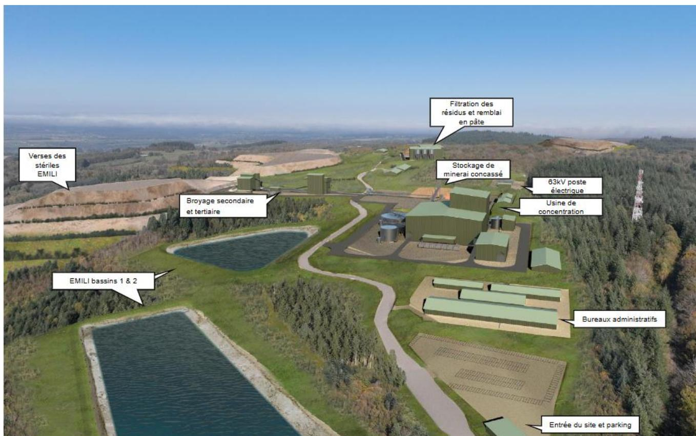
*Figure 2 : Plan du site minier de Beauvoir et de l'usine de concentration*
