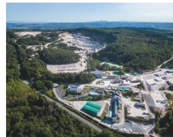
FIG. 17 - VUE GÉNÉRALE SUR LA CARRIÈRE DE BEAUVOIR ET DE SES INSTALLATIONS ASSOCIÉES
