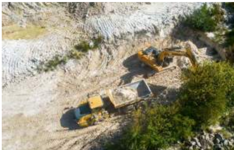
Figure 67 : Exemple d'une pelle hydraulique chargeant un tombereau dans la carrière de kaolin
