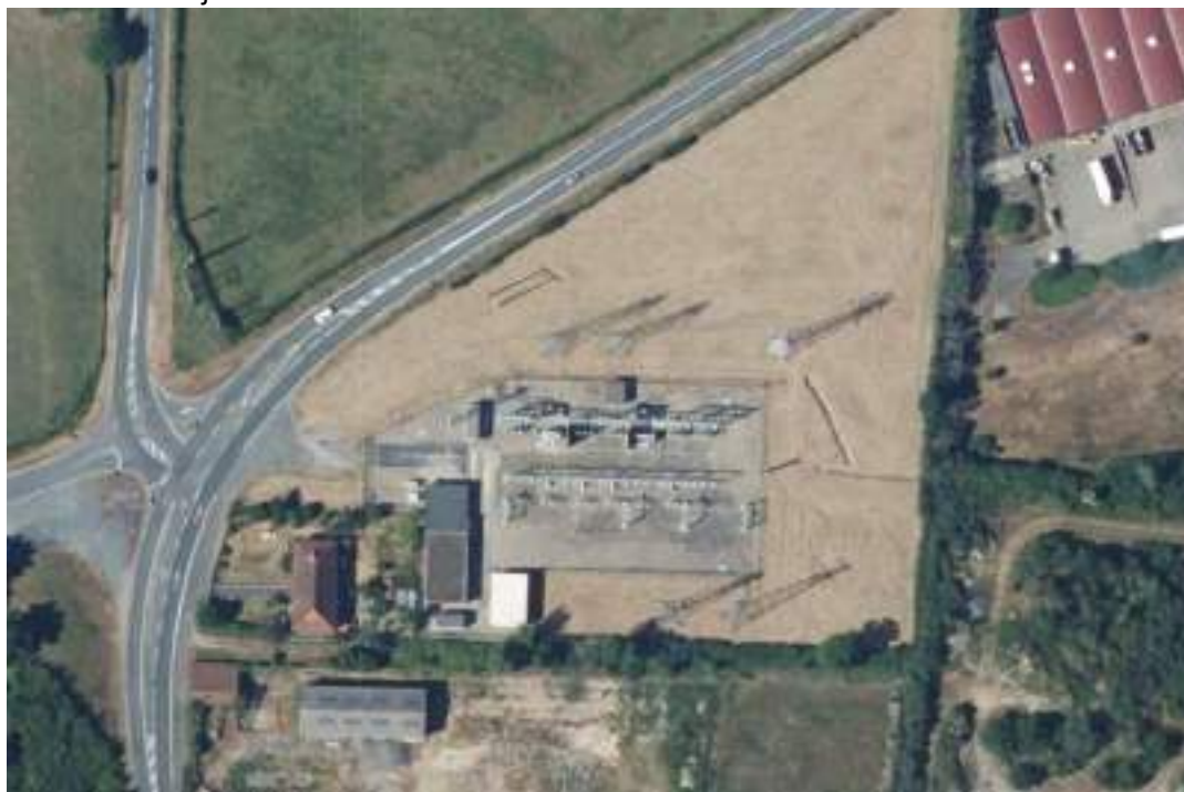
Figure 65 : Vue aérienne du poste électrique de la Durre (Source – RTE)
