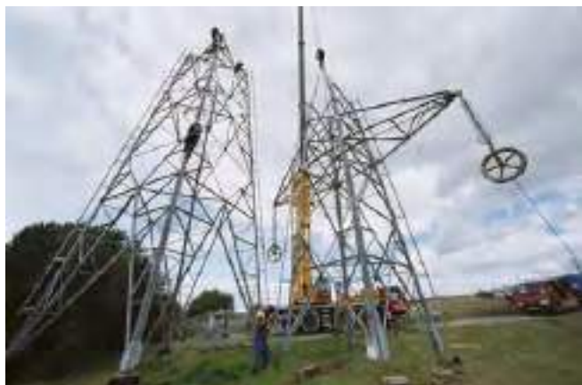
Figure 78 : Levage des supports à la grue (Source – RTE)
