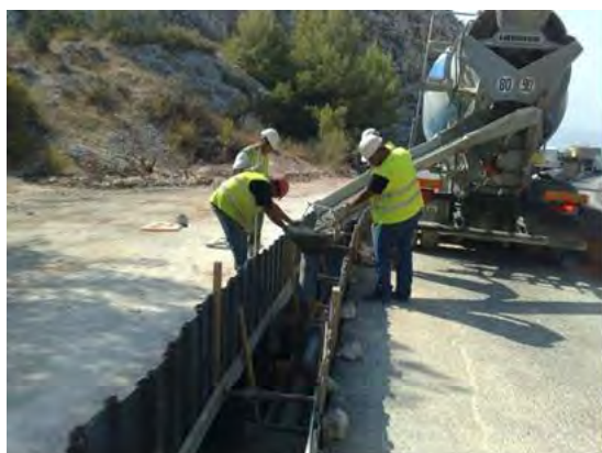
Coulage du béton.
