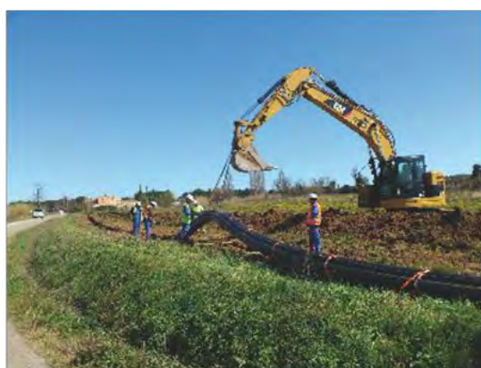
Pose des fourreaux PEHD en pleine terre.
