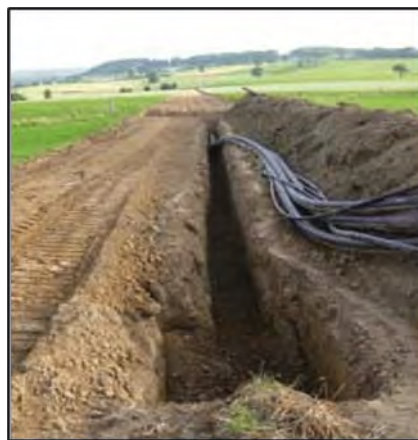
Figure 41 : Photo d'une pose PEHD en pleine terre (Source - RTE)
