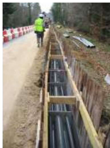
Figure 39 : Photo d'une pose en fourreau PVC dans du béton (Source – RTE)
