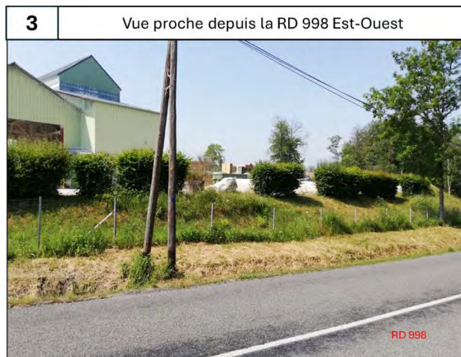
Figure 209 : Vue extérieure du site de Beauvoir (1/3)
